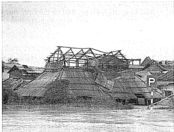
Hình ảnh thiệt hại do bão số 9 năm 2009 gây ra tại Hòa Phong, Hòa Vang thành phố Đà Nẵng
